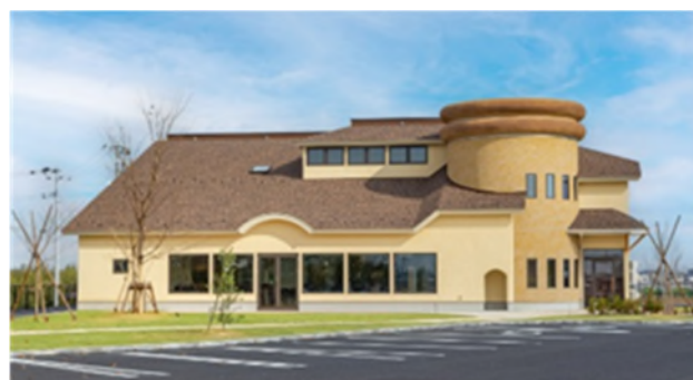
▲ 高揃テラス外観。同店舗ウェブサイト ( https://hanzawakeiran.co.jp/takadamaterrace ) より。
